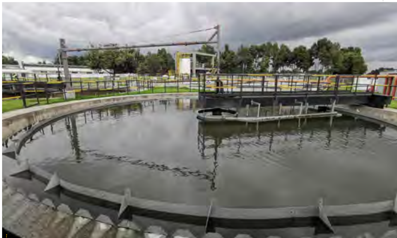
Wastewater treatment plant, Aeropuerto El Dorado.
