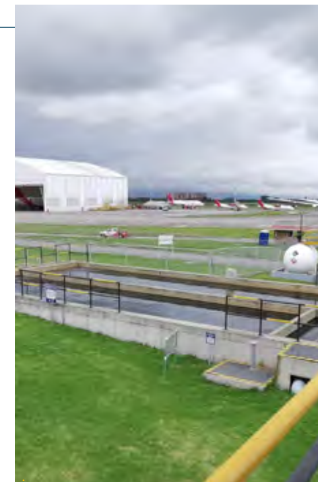
▶ Wastewater treatment plant, Aeropuerto El Dorado.
