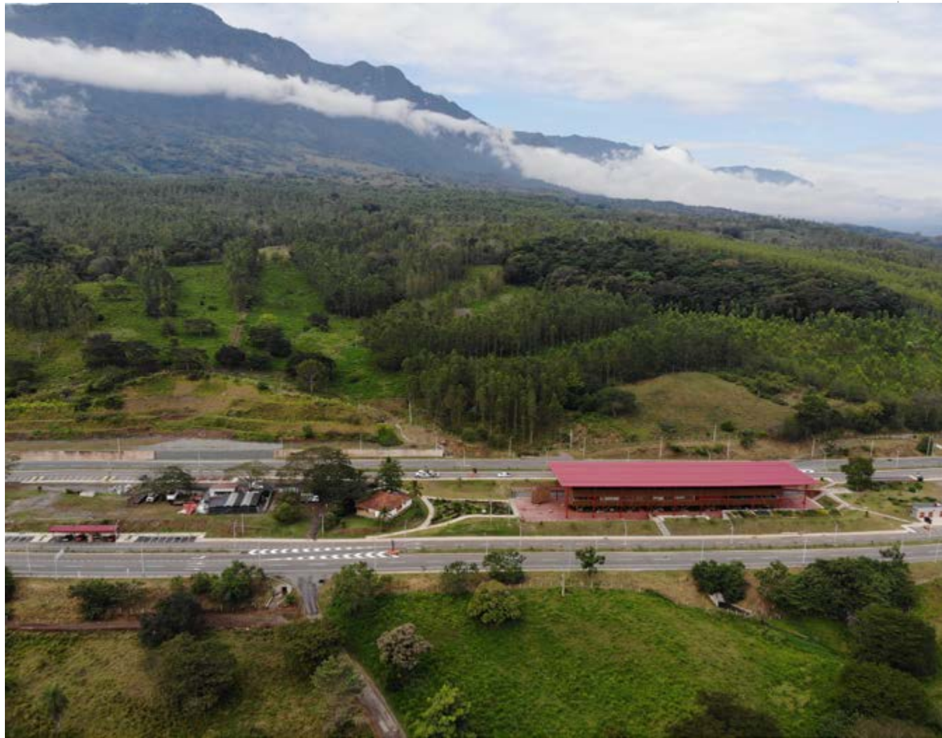
Centro de control de operaciones Conexión Pacífico 2.
