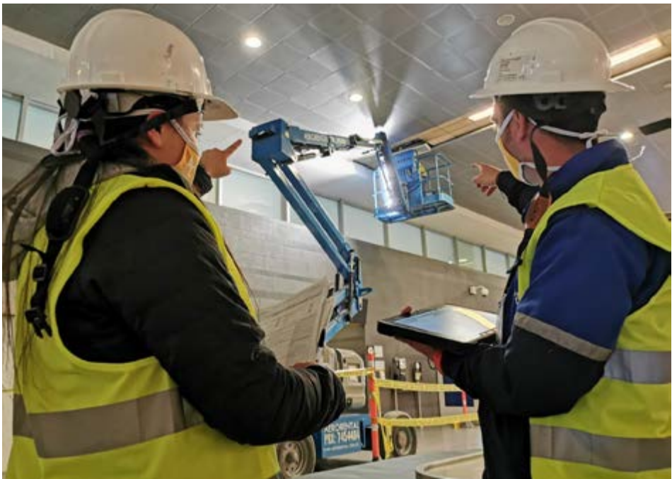
Cambio de luminarias en Aeropuerto El Dorado.
