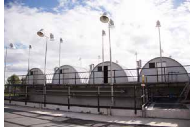
Planta de tratamiento de aguas residuales, Aeropuerto Mariscal Sucre.
