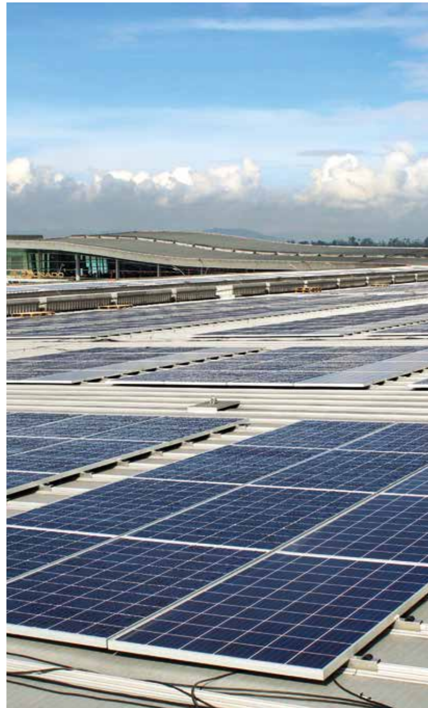
Paneles solares Aeropuerto El Dorado.
