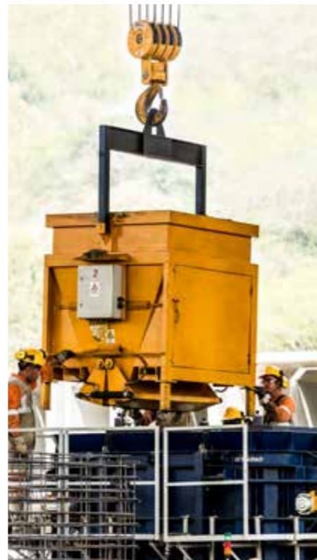
Planta de prefabricados Conexión Pacífico 2.
