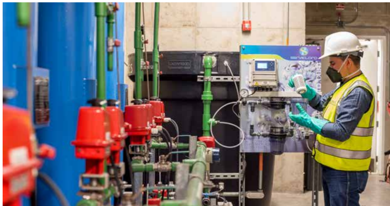
Planta de tratamiento de aguas residuales Aeropuerto El Dorado
