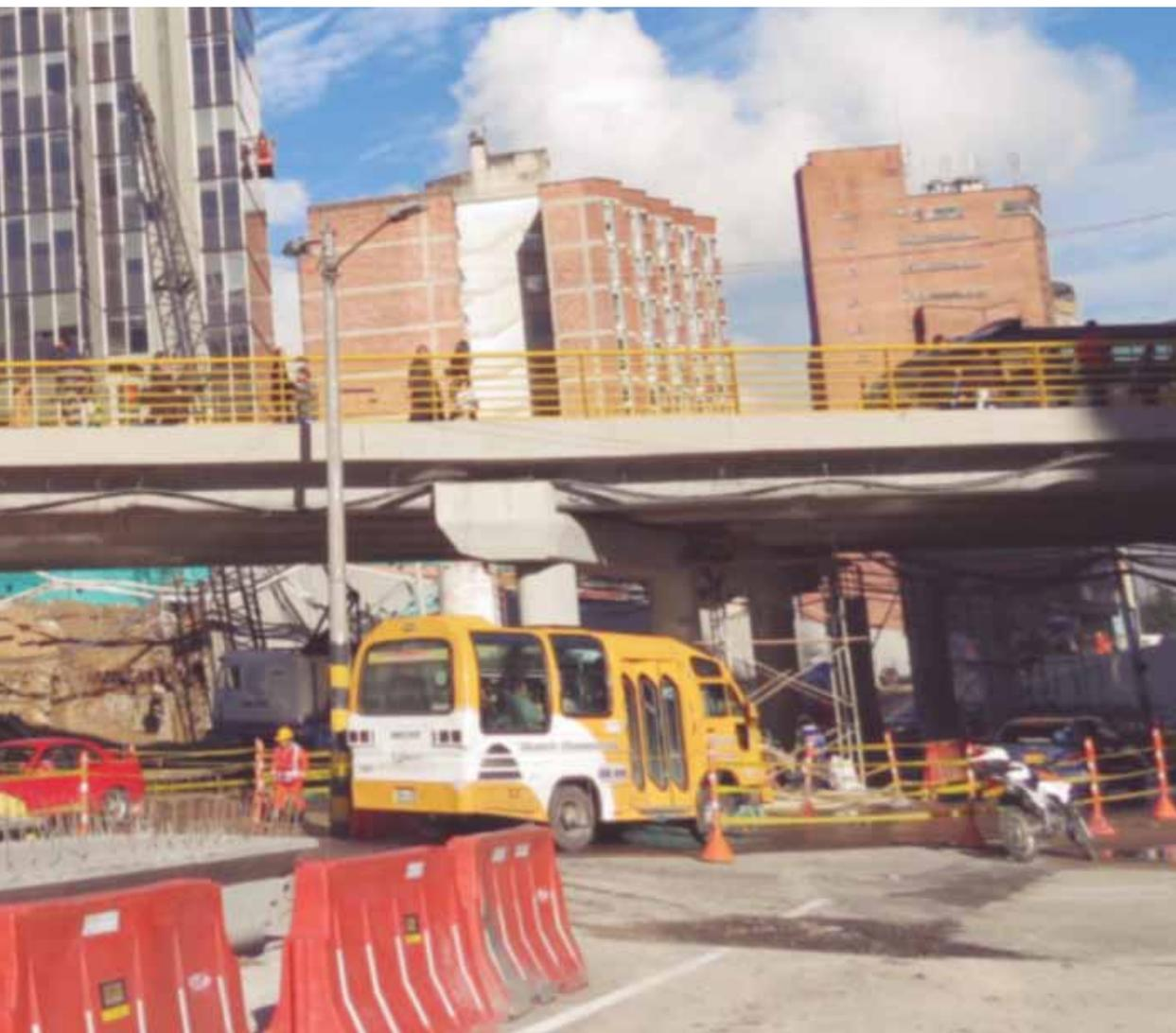
Asimismo se completó el puente oriental de la carrera 13, que estaba proyectado construirlo en una sola fase, pero ante el alto tránsito de la zona, se construyó en dos fases o dos puentes adosados lado a lado.
