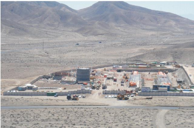
Este proyecto, ubicado en la zona de Cardones, en la III Región de Chile, perteneciente al Sistema Interconectado Central, tiene una capacidad instalada de 96 MW con base a petróleo distribuido en 4 naves con un total de 60 grupos electrógenos P2000 fabricados por FG WILSON en Belfast-UK.
