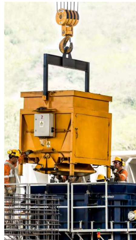
Prefabricated concrete plant, Conexión Pacífico 2, Colombia
