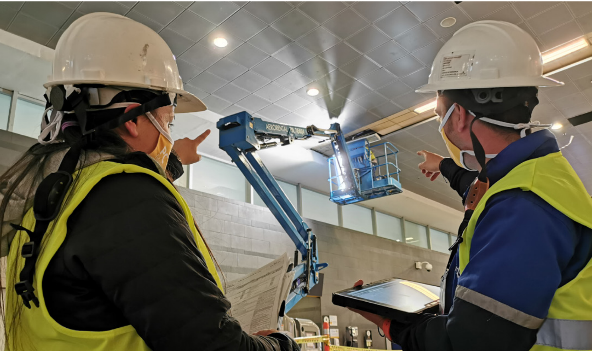
The Retrofit Lighting System at Aeropuerto El Dorado
