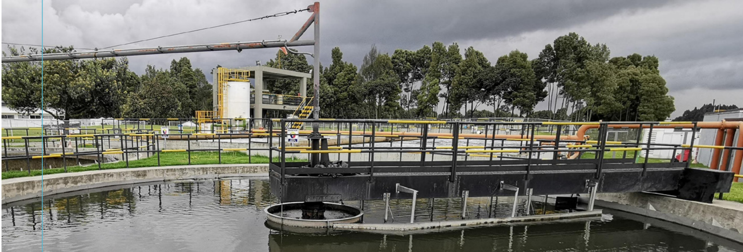
The waste water treatment plant of Aeropuerto Internacional El Dorado.
